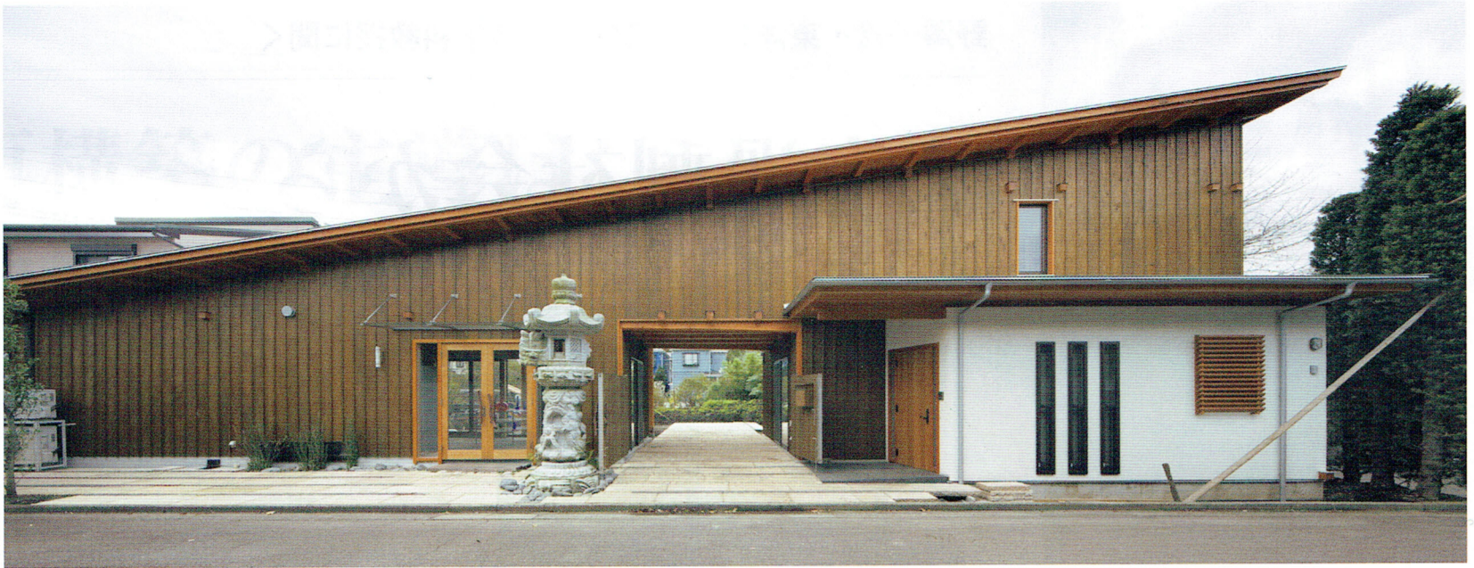
北側から見た外観。ピロティにより「内と外」に連続性を持たせている
